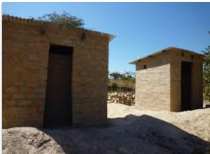
▲完成した2棟のトイレ
