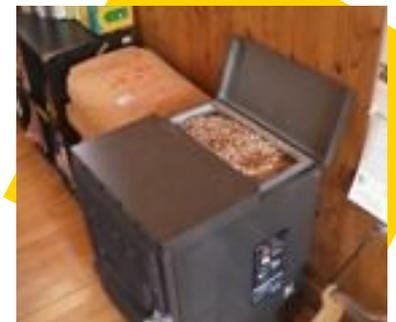
\* ペレットストーブ：木質ペレットを燃料とするストーブ。ペレットの燃焼でCO2は発生するが、炭素循環内の総量としては増加しない点が化石燃料とは異なる。
