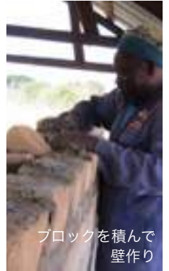
内壁の整備作業のようす
