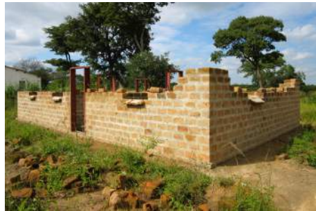
▲建設の進捗状況
