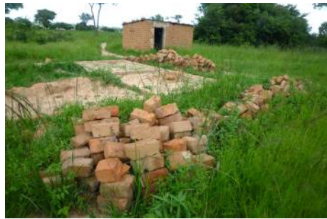
▲コミュニティが作っていた基礎部分。レンガはもちろん彼らが焼いています。
