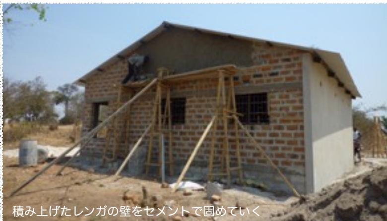
積み上げたレンガの壁をセメントで固めていく
