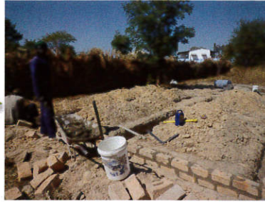
▲基礎工事開始
