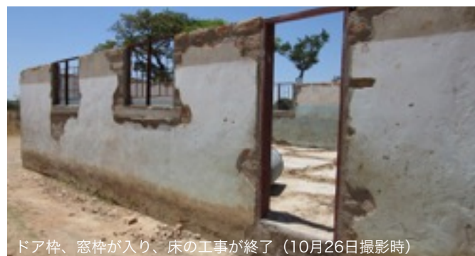
模様に見えるのは砂。床にセメントを流し込んだ後、水をセメントに吸わせることでセメントにひびが入るのを防ぎます。砂を堤防のようにし、水たまりを作っていました。
