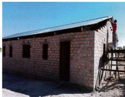
▲工事開始から一ヶ月
