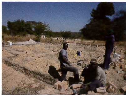
▲基礎工事開始
